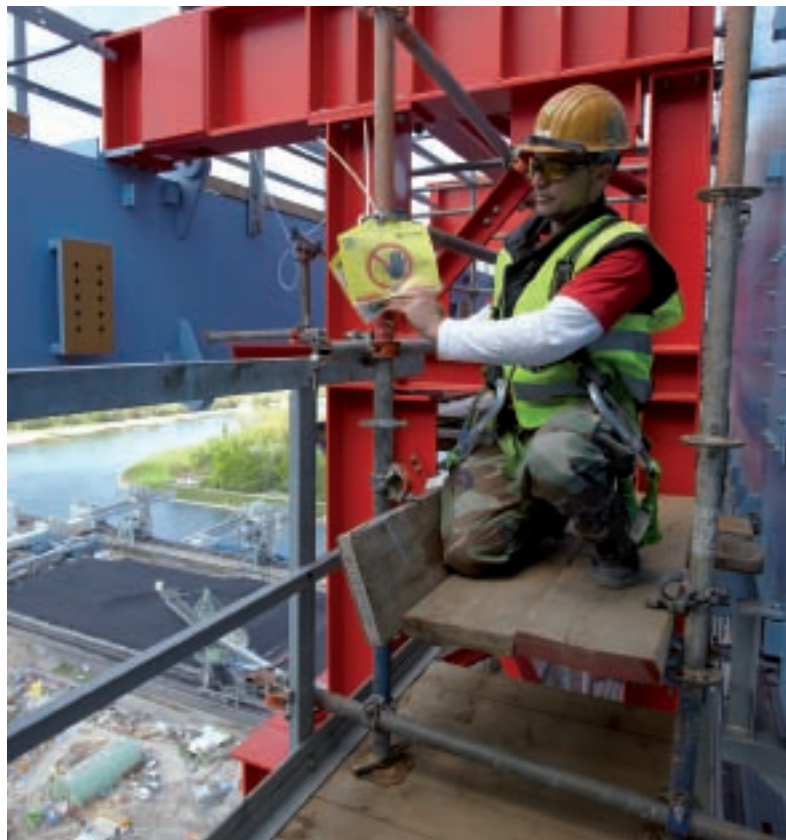
Regelmäßige Kontrolle der Gerüste: Bauleiter Ali Kassem prüft die Sicherheit der einzelnen Gerüستهile.
