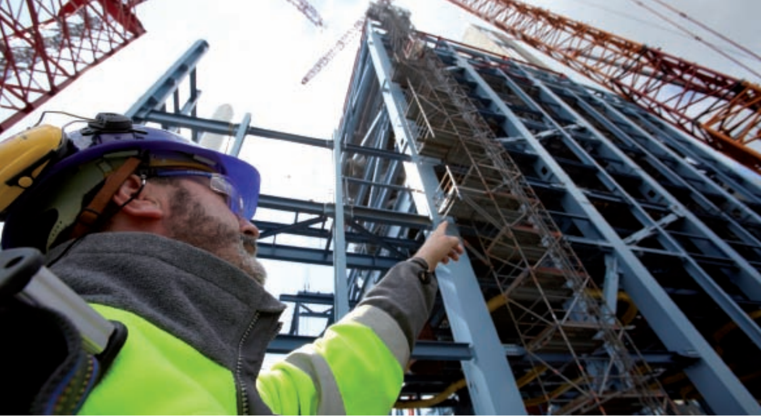
Sicherheitskoordinator Ralf Hammesfahr prüft bei einem Kontrollgang über die Baustelle mögliche Gefährdungen.
